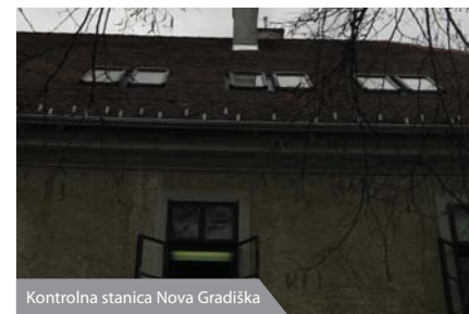
Kontrolna stanica Nova Gradiška
